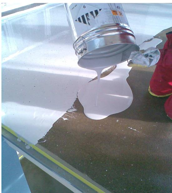
*La premessa fondamentale é legata alla qualità del supporto, al quale le resine devono aderire perfettamente e senza formare pori e bolle. La preparazione del supporto e le condizioni di posa sono determinanti.*
