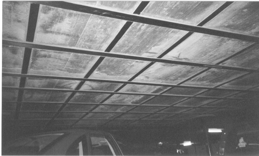
Rinforzo bidirezionale (piastra) con lamelle in fibre di carbonio
